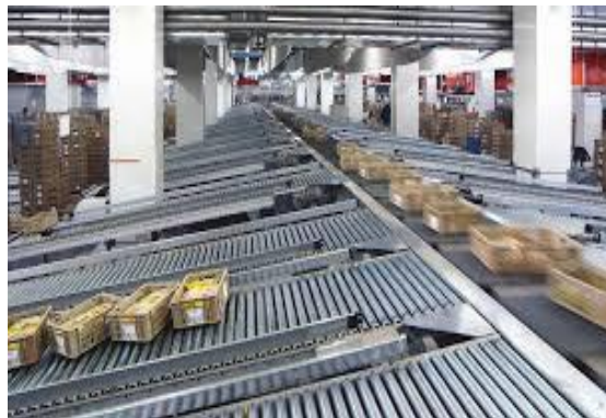
Gekühlte Kommissionierung (Geko-Anlage, 2003)
